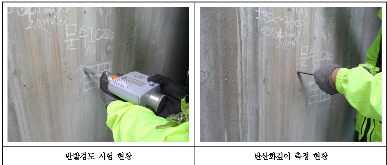
【사진 22.4.1】 콘크리트 내구성조사 현황
