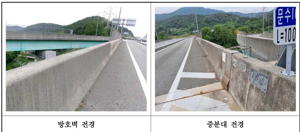
【사진 22.3.25】 방호벽 및 중분대 전경
