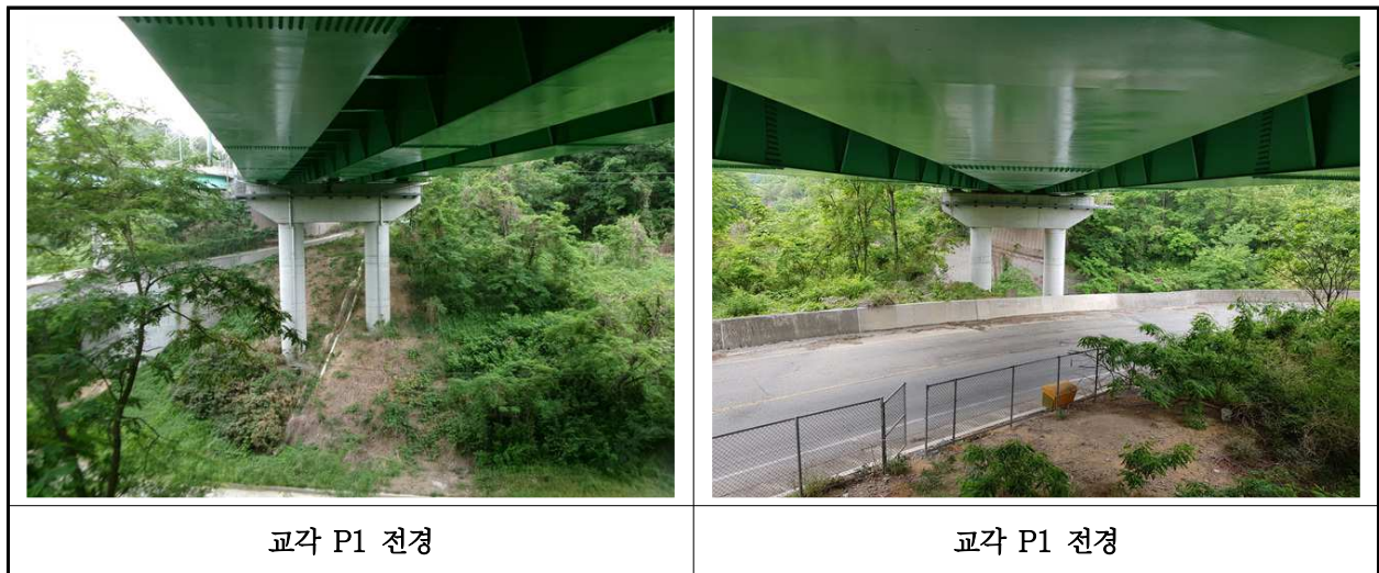
【사진 22.3.11】 교각 전경
