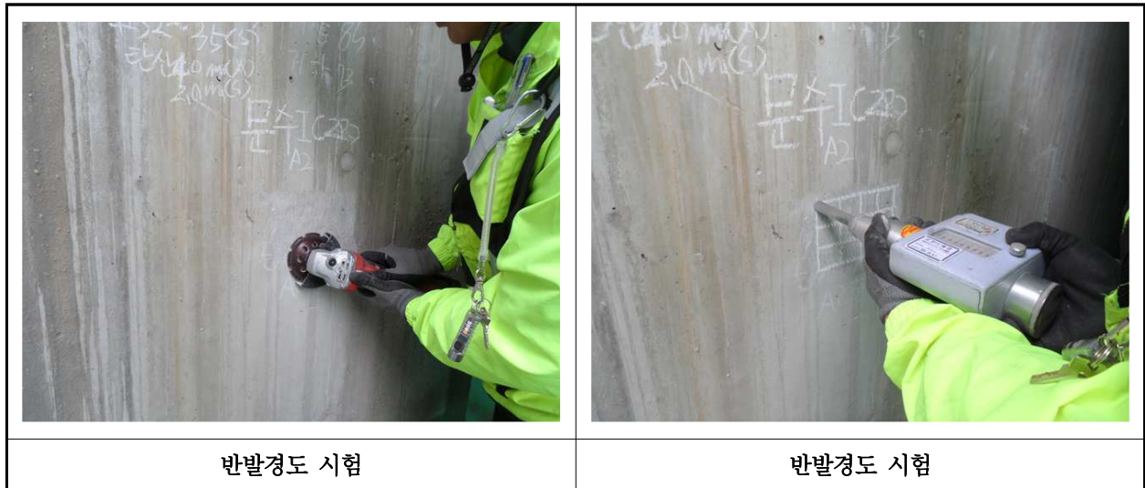
【사진 22.4.2】 반발경도시험 현장사진
