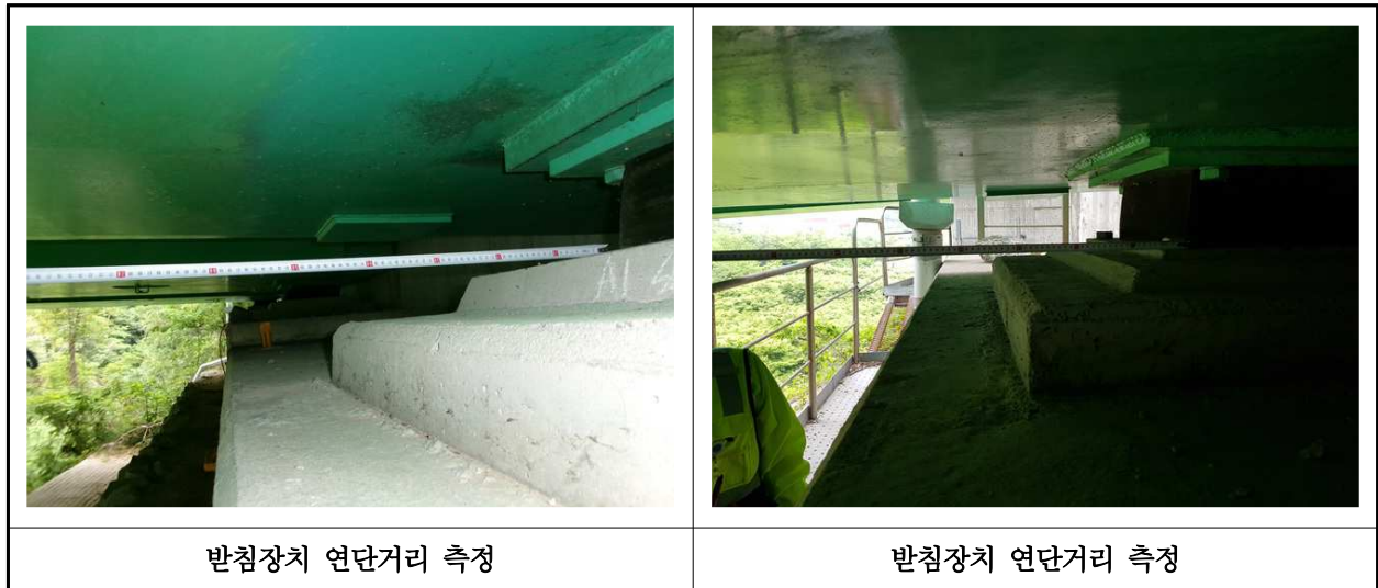
【사진 22.3.16】 교량반침장치 연단거리측정
