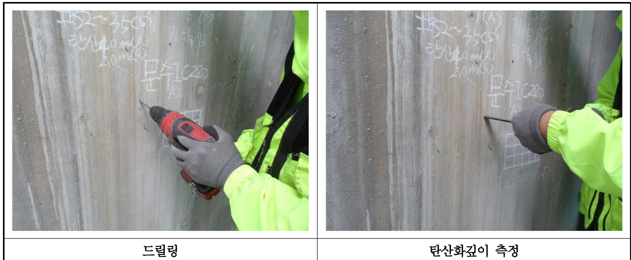
【사진 22.4.3】 탄산화 깊이 측정 현장사진
